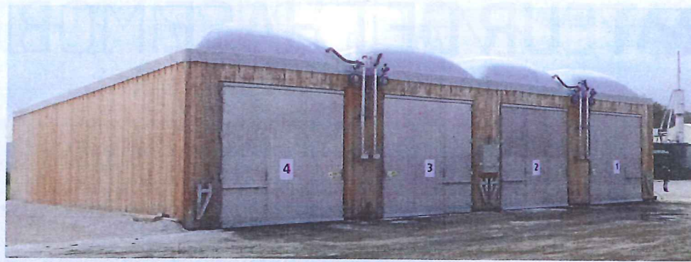
Quatre digesteurs pour une production de 150 kW Quatre digesteurs sont disposés en parallèle. Il s'agit de garages fermés hermétiquement qui absorbent 7 000 t de matières premières/an, et 100 m 3 de jus de percolation nécessaire pour amorcer les fermentations.
