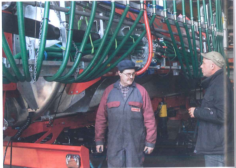
↑ Unité de méthanisation, une mise au point réussie.
